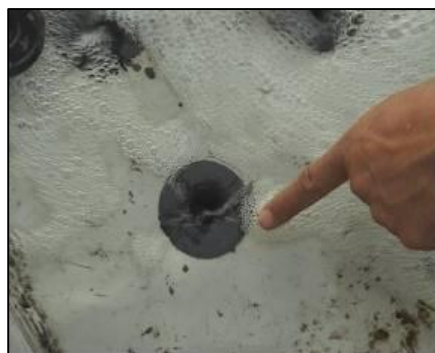
ดูแลความสะอาดรางน้ำของ Cooling Tower
