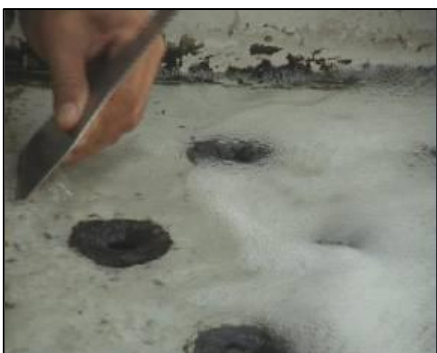
ดูแลความสะอาดรางน้ำของ Cooling Tower
