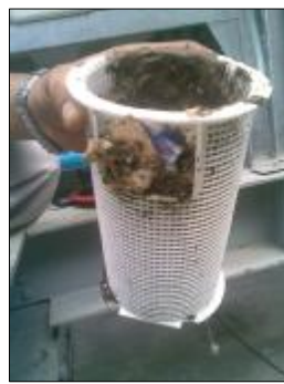
ดูดตะกอนออกจากถาด Cooling Tower
