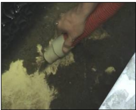
ดูดตะกอนออกจากถาด Cooling Tower
