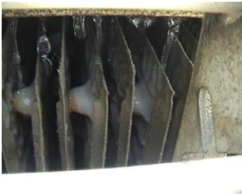
บริเวณที่มีน้ำ ไหลผ่านตลอดจะสะอาดกว่าบริเวณที่น้ำไม่สามารถไหลไปถึง แต่จะสังเกตเห็นว่าคราบสกปรกที่เกาะอยู่นั้นเริ่มอ่อนตัว
