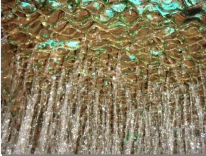
สภาพตะกรันและเมือกที่เกาะตาม Fill ของ Cooling Tower
