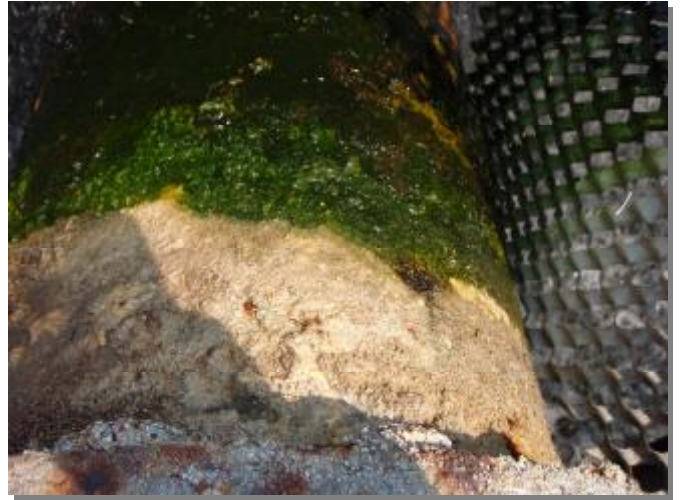
สภาพตะกรันและเมือกที่เกาะตาม Fill ของ Cooling Tower
