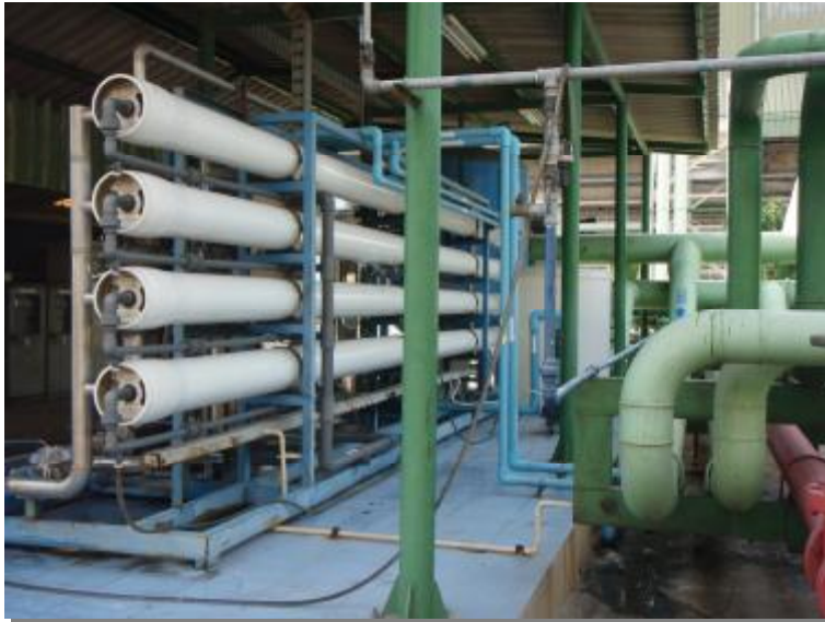
มีการใช้เครื่อง RO ในการปรับสภาพน้ำก่อนการจ่ายเข้าไปในระบบ
